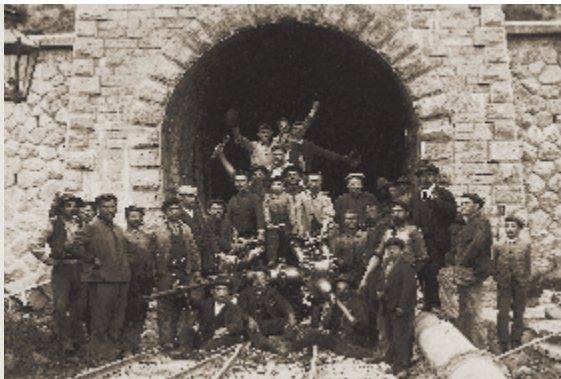
Tunnelarbeiter und Ingenieure in Spinas
