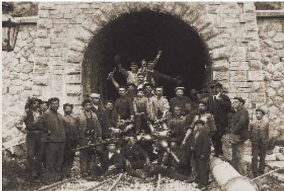
Tunnelarbeiter und Ingenieure in Spinas
